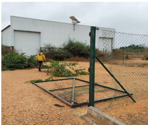
Fotografias das infra-estruturas do PIR do Tomboco obtidas no terreno (2023)
